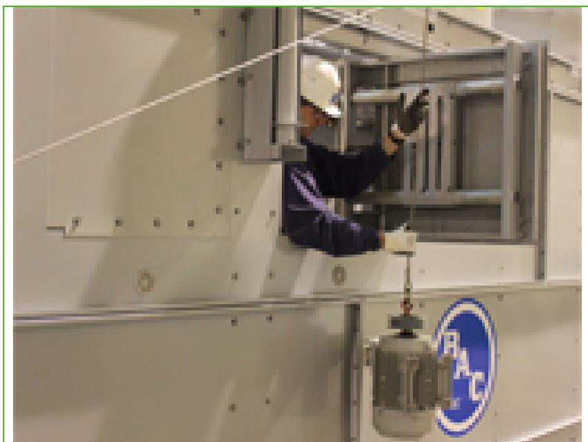
Mit dem optionalen Motorhebe-Davit kann der Motor sehr einfach von seiner Basis abgesenkt, oder **zu seiner Basis angehoben** werden, ohne dass ein Gerüst oder zusätzliches Hebezeug benötigt wird. Die Motorbasis selbst kann aus der Rückseite des Geräts geklappt werden, um ein Absenken des Motors außerhalb des Geräts zu ermöglichen
