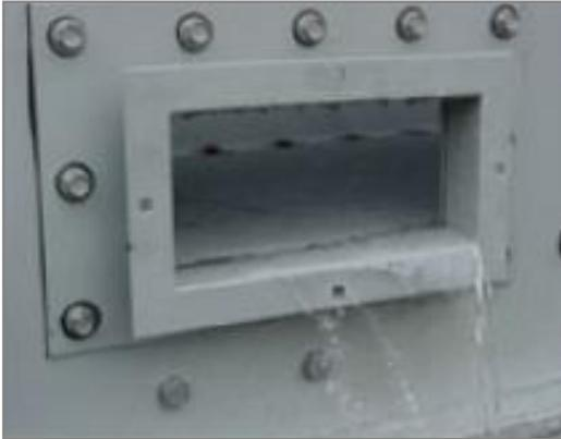
Die Reinigungsöffnung **erleichtert die Beseitigung von Schluff und Schlamm** aus dem Kühlturmbecken beim Reinigen und Spülen der Wanne. [Mehr erfahren](#)
