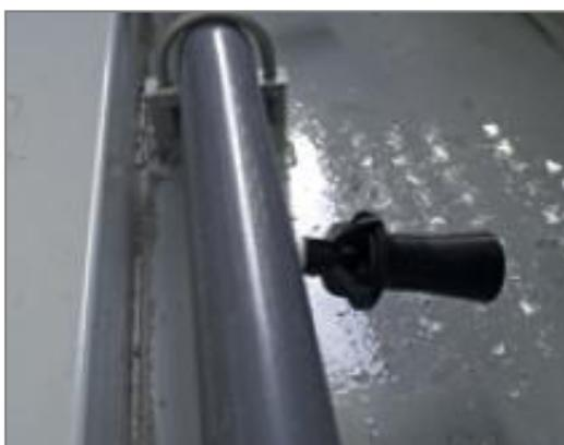
Die Wannensabsaugung **verhindert das Ansammeln von Sedimenten im Kaltwasserbecken** des Geräts. Ein komplettes Rohrsystem einschließlich Düsen ist **für den Anschluss an eine Seitenstromfilteranlage** im Becken des Turms eingebaut. [Mehr erfahren](#)
