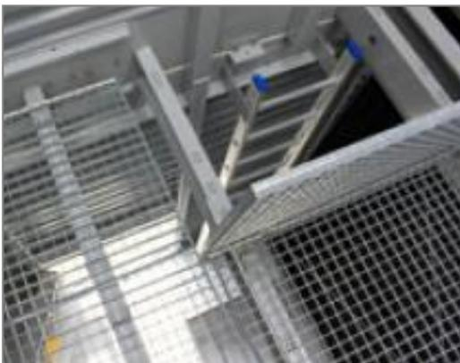
Eine innere Plattform hilft Ihnen beim **Zugang zur inneren Oberseite des Geräts** und bei der sicheren Inspektion Ihrer Kühltürme. [Mehr erfahren](#)
