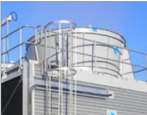
**Um die Leistung in umschlossenen Räumen zu steigern**, wählen Sie einen Auslasszylinder oben am Lüfterzylinder. [Mehr erfahren](#)
