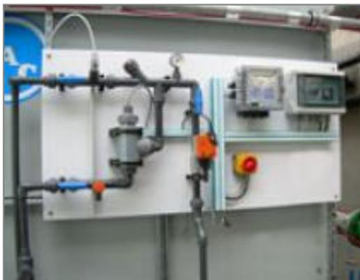
Geräte zur Kontrolle der Wasserbehandlung sind erforderlich, um eine ordnungsgemäße **Wasserpflege des Kühlturms** sicherzustellen. Dies trägt nicht nur zum Schutz der Komponenten und Füllkörper, zur Kontrolle von Korrosion, Kalkbildung und Fouling bei, es vermeidet auch die Verbreitung schädlicher Bakterien wie **Legionellen** im Umlaufwasser. [Mehr erfahren](#)
