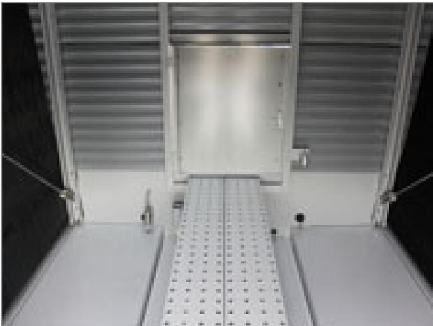
Der interne Laufsteg erleichtert den **Zugang zum Kaltwasserbecken und macht** Inspektion und Wartung **sicherer und einfacher**.
