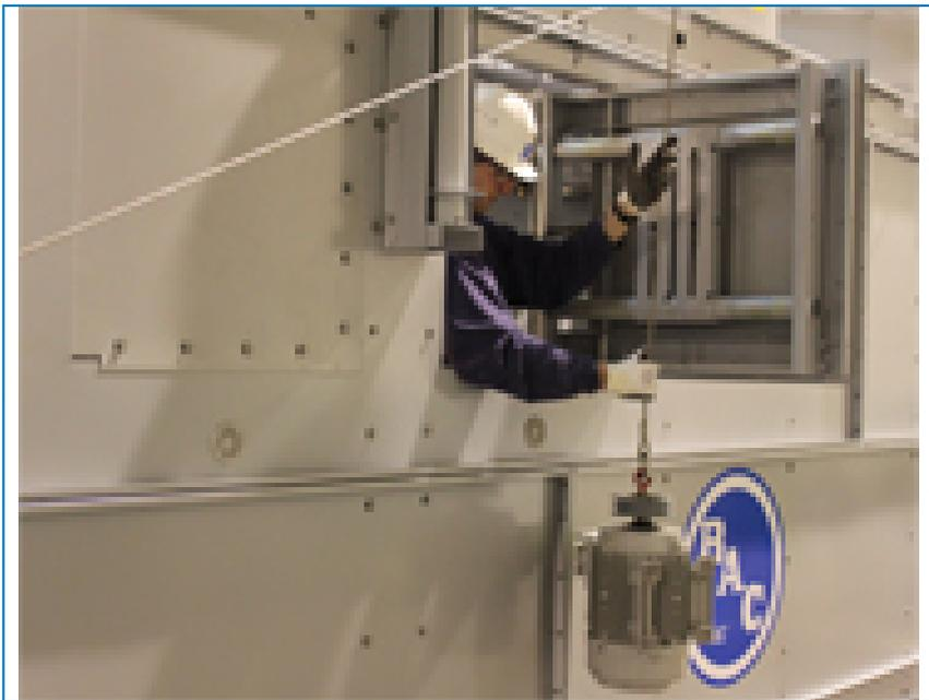
Mit dem Motor-Entfernungs-Davit kann der Motor **[ganz einfach in die Motorkonsole abgesenkt](#)** oder **aus ihr herausgehoben werden**, ohne dass zusätzliches schweres Gerüstmaterial erforderlich ist. Die Motorkonsole selbst wird hinten aus dem Gerät gedreht, sodass Sie den Motor außerhalb des Geräts absenken können
