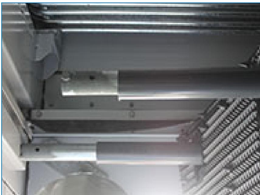
El uso de vigas de soporte de relleno telescópico facilita la extracción y la sustitución de las láminas de relleno.
