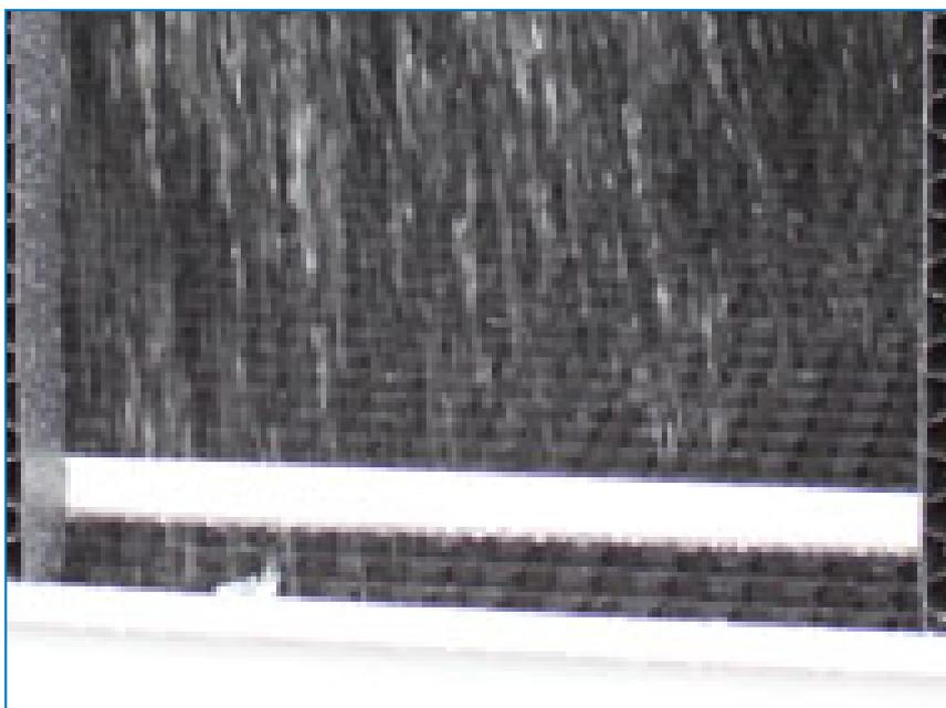
Les silencieux à eau du bassin **réduisent le bruit** de l'eau qui tombe dans le bassin. Ils sont facilement démontables au sein de **modules** pour l'inspection ou le nettoyage du bassin.
