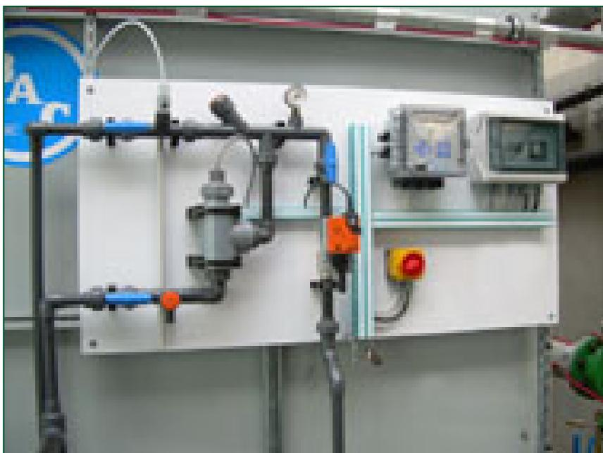
BAC propone un'ampia **gamma di dispositivi automatici di trattamento dell'acqua** per controllare corrosione, incrostazioni, contaminazioni e crescita microbologica nei sistemi di raffreddamento dotati di condensatori BAC.
