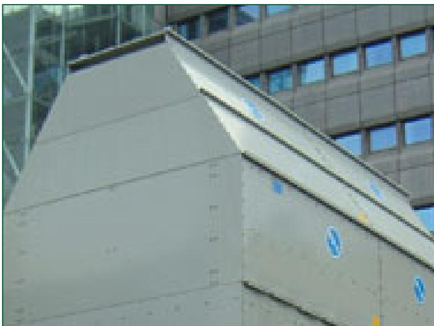
I cappelli di scarico consentono di fare fronte alle limitazioni di configurazione **innalzando lo scarico dell'unità** al di sopra delle pareti adiacenti e aumentando la velocità dell'aria di scarico, in modo da **ridurre il rischio di ricircolo** in spazi ristretti.
