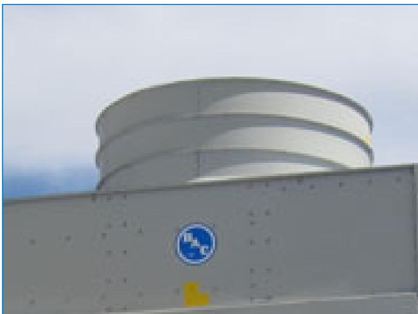
Le torri di raffreddamento PTE montano **ventilatori assiali silenziosi e a basso consumo energetico** ma, per ridurre ulteriormente la rumorosità, possono essere integrate mediante un dispositivo di [attenuazione acustica](#):
