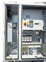
**Ora sono disponibili controlli adiabatici con trasmissioni VFD per il retrofit** su unità di vecchia generazione con regolazione a fasi, con funzionalità e vantaggi aggiuntivi: meno rumorosità, meno consumo di acqua e di energia.
