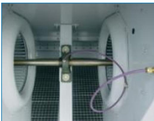
Le linee di lubrificazione estese, con ingrassatori facilmente accessibili, si possono utilizzare **per lubrificare** i cuscinetti dell'albero del ventilatore. [Maggiori informazioni...](#)
