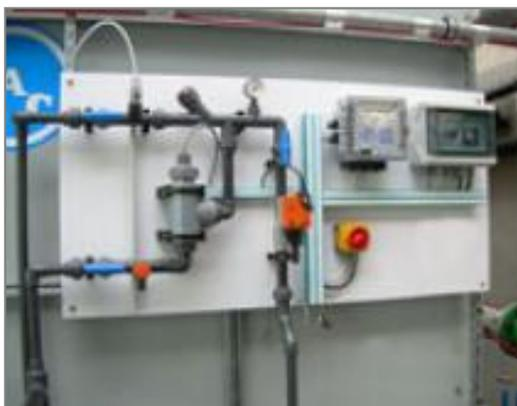
Чтобы обеспечить правильный **уход за водой в градирне**, требуются устройства для контроля обработки воды. Это не только помогает защитить компоненты и пакет наполнителя, контролировать коррозию, известковый налет и запахи, но и предотвратить размножение в циркулирующей воде вредных бактерий, включая **легионеллу**.
