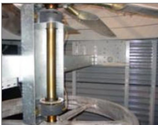
**Для смазки** подшипников вала вентилятора могут быть использованы удлиненные смазочные линии с легко доступными смазочными фитингами. [Узнайте больше.](#)
