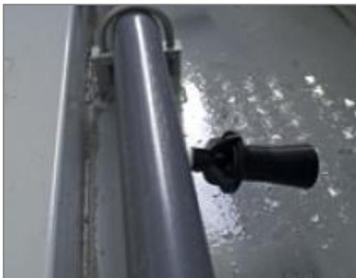
Трубопровод очистителя поддона **предотвращает накопление осадка в бассейне холодной воды** изделия. Полная система трубопроводов, включая форсунки, монтируется в бассейне градирни и **далее подсоединяется к оборудованию фильтрации с отводным контуром.** [Узнайте больше](#)
