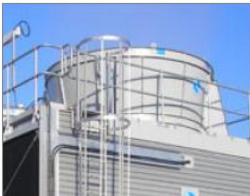
Для повышения производительности в **ограниченных пространствах**, выберите патрубки для увеличения скорости на выходе, которые устанавливаются наверху цилиндра вентилятора. [Узнайте больше](#)
