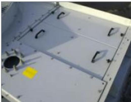
Крышки распределительных бассейнов наверху установок **предотвращают накопление мусора** в бассейнах распределения воды.
