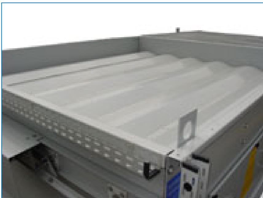
**ДПЗ предотвращают воздушный поток через установку** когда она выключена.
