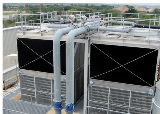
Filtros de acción múltiple instalados en la mitad superior de torres de enfriamiento BAC S3000 con deflectores antiguos en la parte inferior
