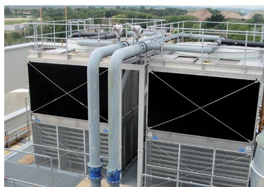
Schermi ingresso aria combinati retrofit per la metà superiore delle torri di raffreddamento BAC S3000 con deflettori tradizionali nella parte inferiore
