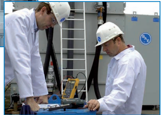
Operación de desincrustación
