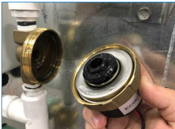
Těleso čerpadla a spirální skříň
