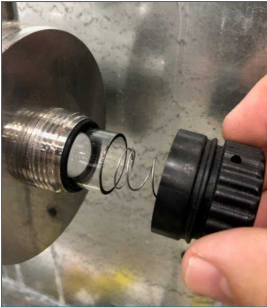
Vyjmutí UV křemenné trubice
