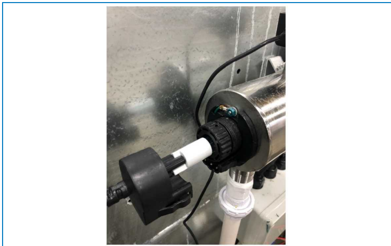
Výměna žárovky
