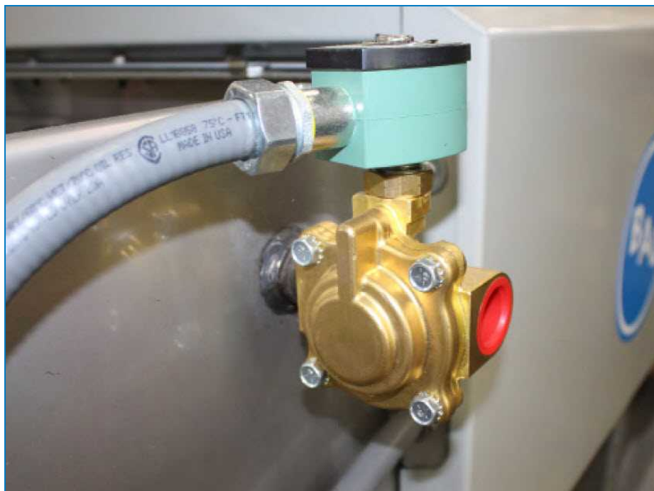
Elektromagnetický ventil vypouštění
