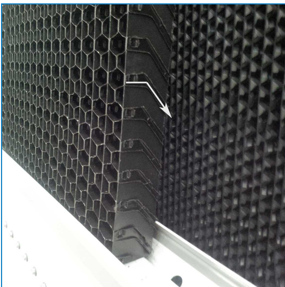
Orientácia kombinovaného krytu nasávania
