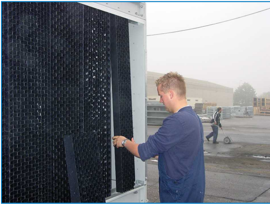
Odstránenie kombinovaných krytov nasávania
