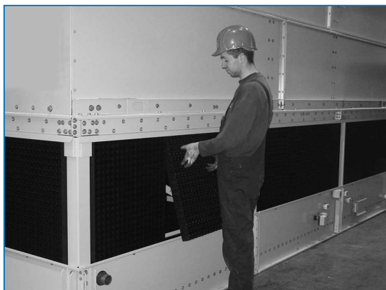
Снятие комбинированных щитов на входе
