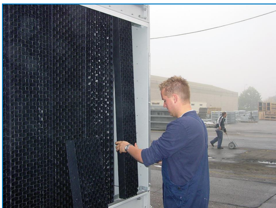
Demontáž kombinovaných krytů sání vzduchu
