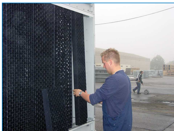
Demontáž kombinovaných krytů sání vzduchu
