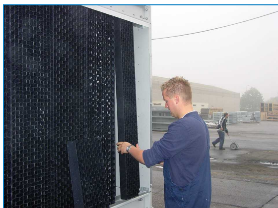
Снятие комбинированных щитов на входе
