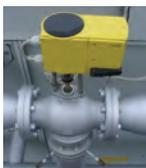
Apparecchiatura per il trattamento dell'acqua      Valvola a 3 vie
