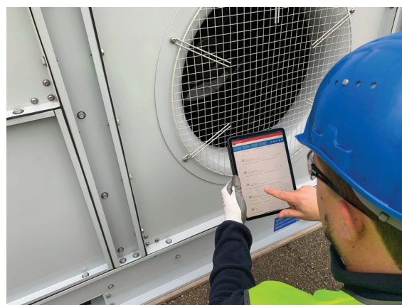
Besplatni pregled na terenu uz BAC Inspect
