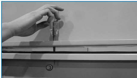
Verwendung des Treibdorns zur Ausrichtung der Schraublöcher
