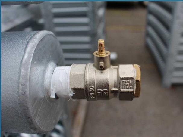
*Oberer Rohrbündelanschluss mit Überdruckventil auf Verdunstungsverflüssigern.*
