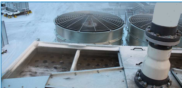
Meleg vízmedence és a vízelosztó tér opcionális fedelei
