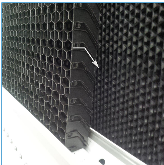
Orientacja zespolonej osłony wylotowej
