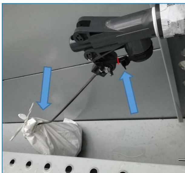
Montaż i owijanie kuli pływaka
