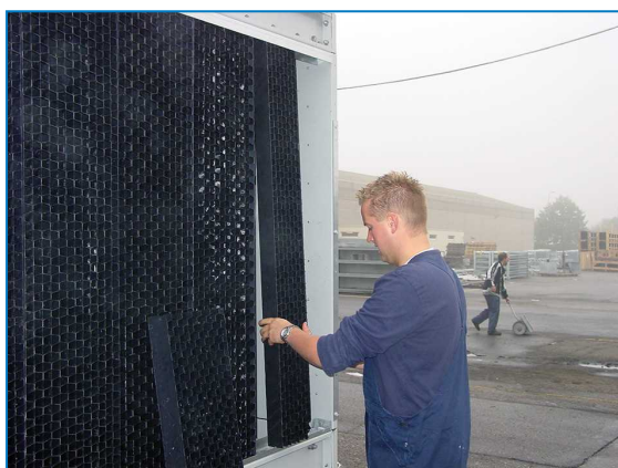
Usuwanie zespolonych osłon wlotowych
