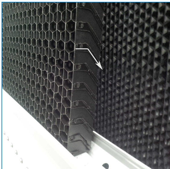
Orientacja zespolonej osłony wlotowej
