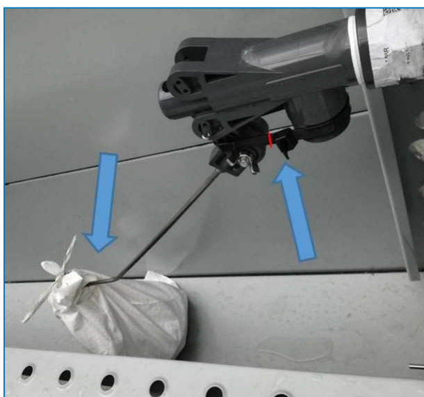
Фиксиране и обвиване на поплавъчна топка
