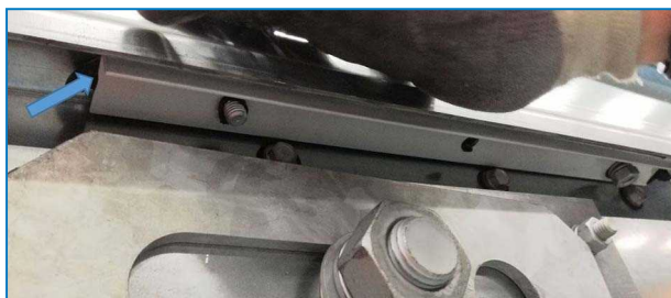
Nainstalovaný těsnicí profil
