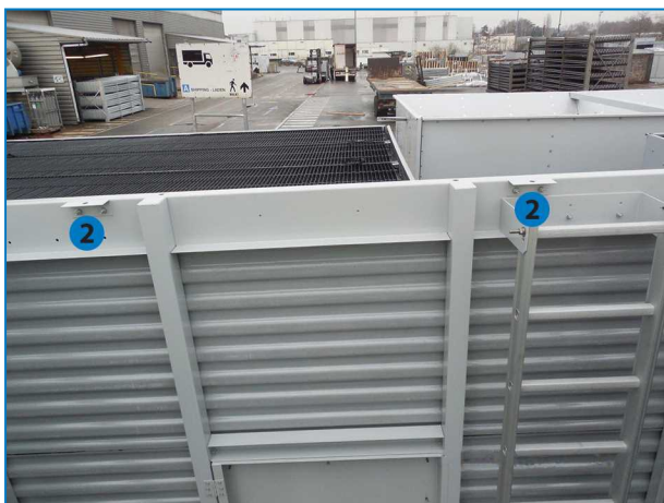
2. Výstrojové vodítko/konzola dolní sekce
