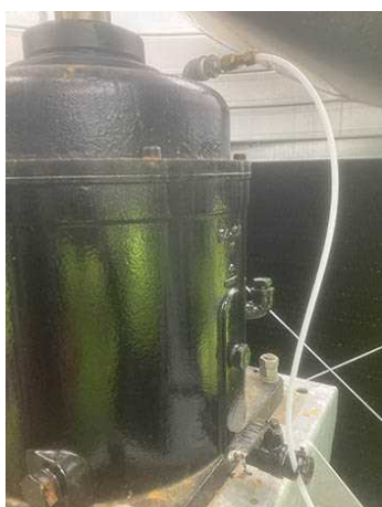
Motor se vzdušným spalováním na převodovce
