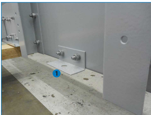
1. Výstrojové vodítko/konzola horní sekce
