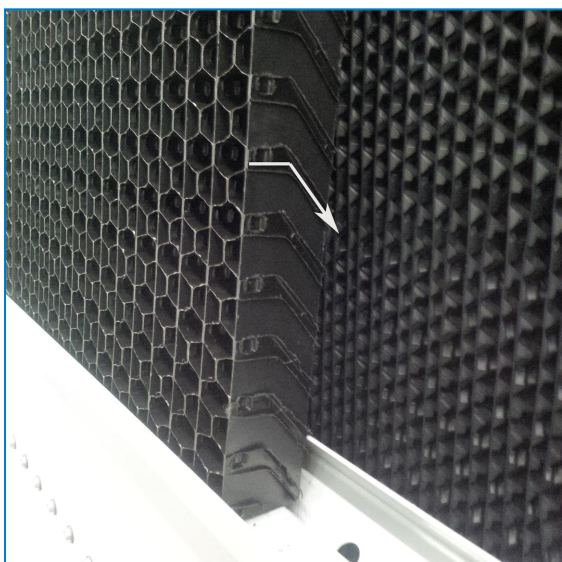
Orientamento dello schermo d'ingresso combinato
