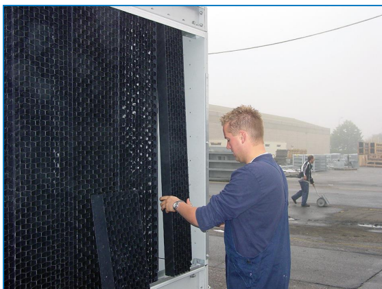
Rimuovere gli schermi d'ingresso combinati.
