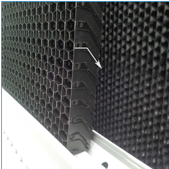
Orientamento dello schermo d'ingresso combinato
