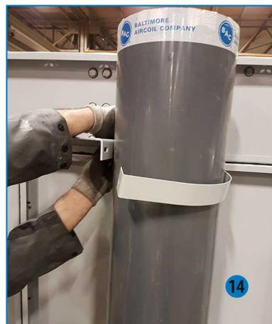
13. Instale o suporte da tubagem da bomba. Retire 3 parafusos da flange superior da secção do tanque e instale o suporte. Utilize o desenho 12D115 para verificar a posição exata para a instalação do suporte.
