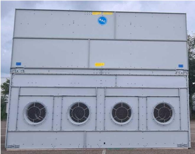
Todos os resguardos dos ventiladores instalados.
