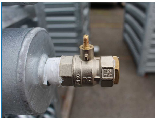
Övre slingkoppling med övertrycksventil på kondensorer.
