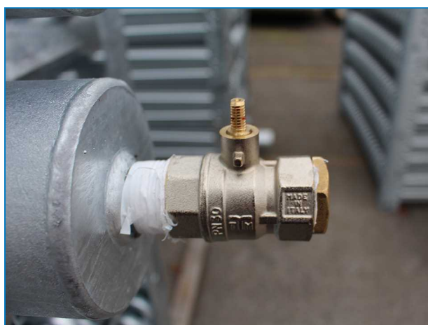
Övre slingkoppling med övertrycksventil på kondensorer.
