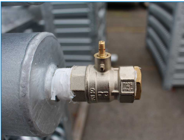
Övre slingkoppling med övertrycksventil på kondensorer.
