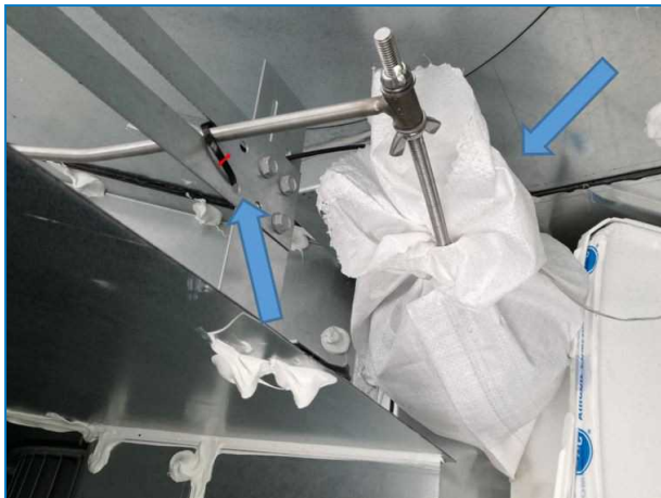
Fiksiranje i omotanje plovak
