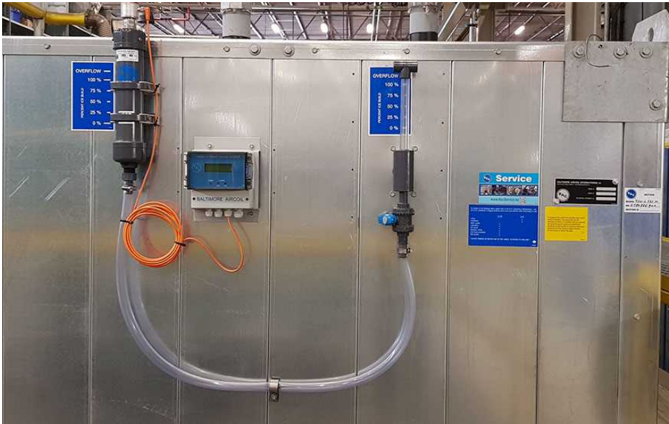
Ice-Logic™ met radarsensor
