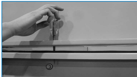
Gebruik van centreerpen om de schroefgaten uit te lijnen
