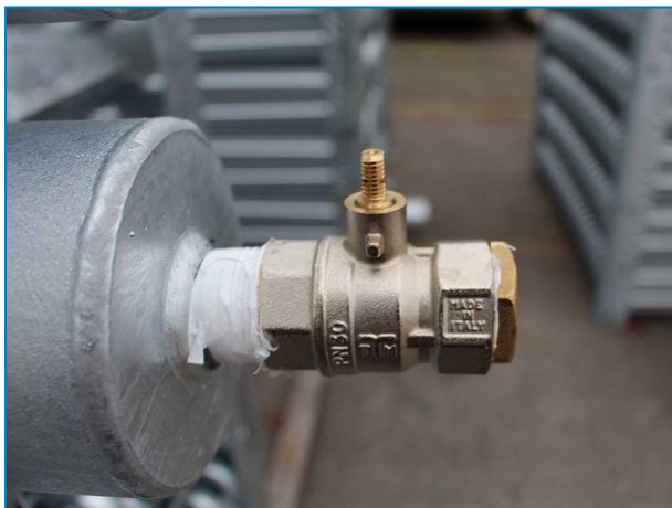
Bovenste batterijaansluiting met drukaflaatklep op condensors.
