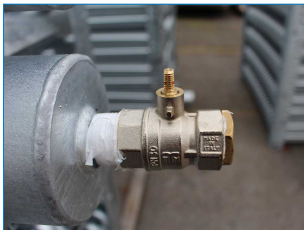
Gornji priključak izmenjivača sa ventilom za otpuštanje pritiska na kondenzatorima.
