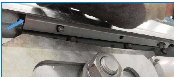
Zamontowany profil uszczelniający
