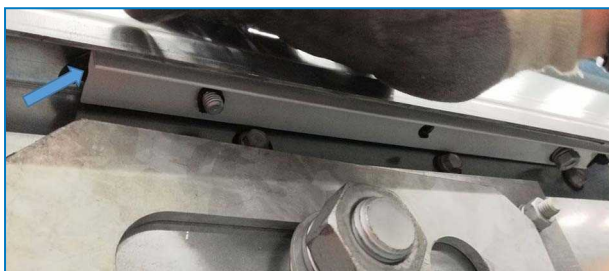
Zamontowany profil uszczelniający
