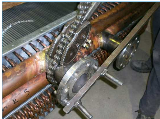
Instalacja przykręcanego kołnierza
