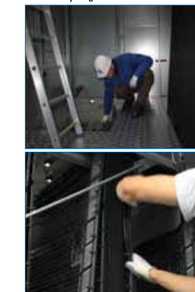
Gepatenteerd BACross-vulpakket voor inspectie en reiniging blad per blad
