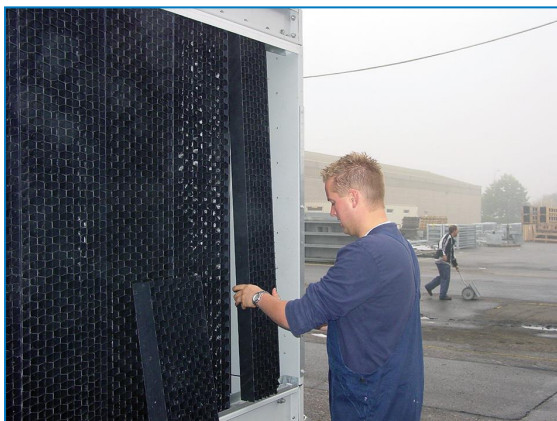
Demontering av kombinerade inloppspaneler
