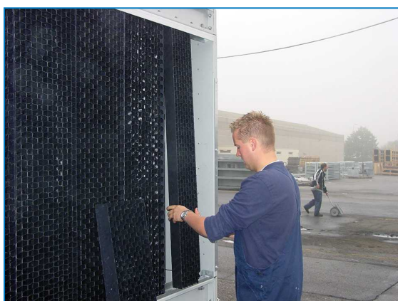
Demontering av kombinerade inloppspaneler
